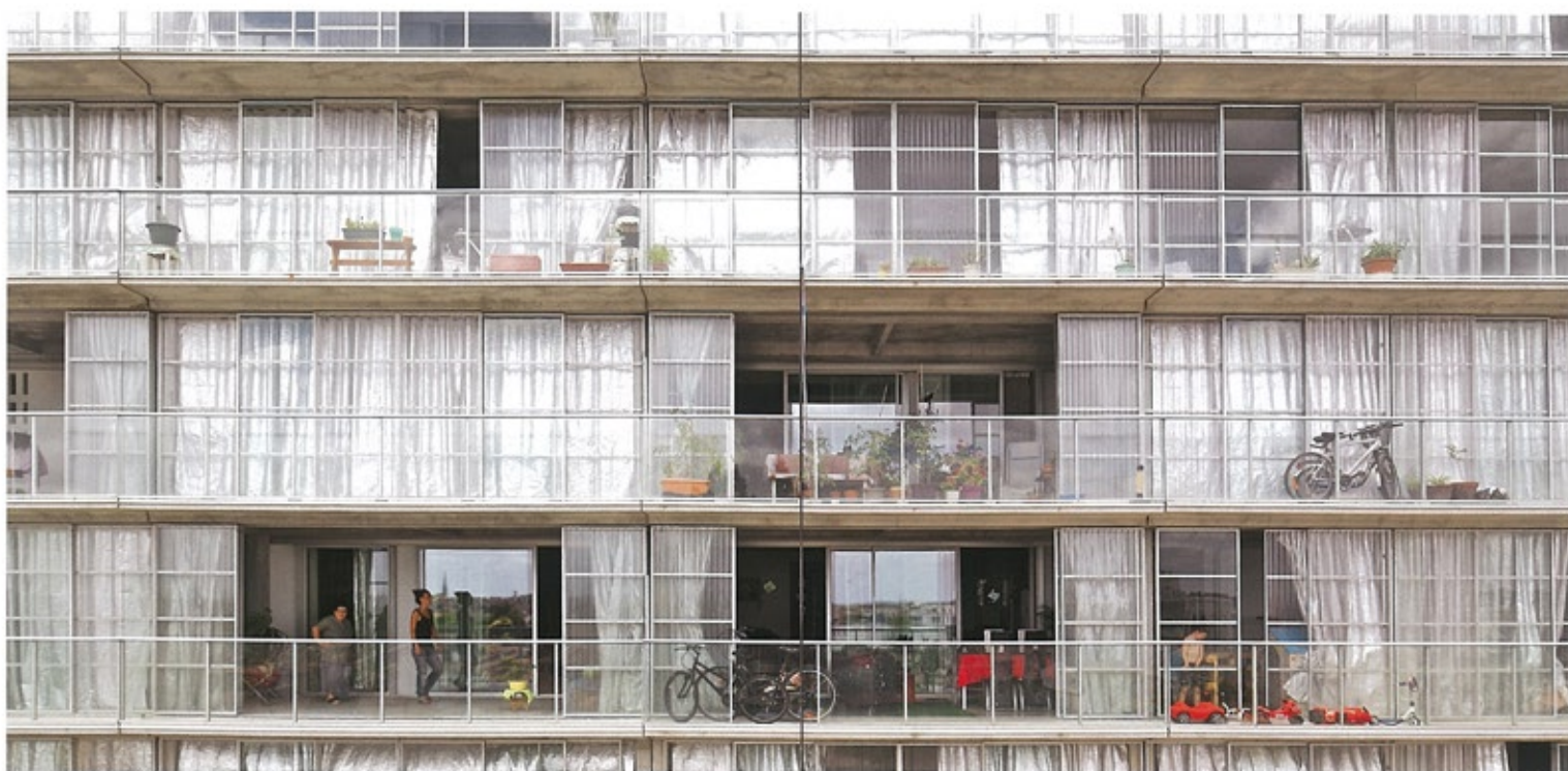
Lacaton Et Vassal + F. Druot, transformación de 530 viviendas en Grand Parc, Burdeos, Francia (2005-2011) Transformation of 530 dwellings in Grand Parc, Bordeaux, France
